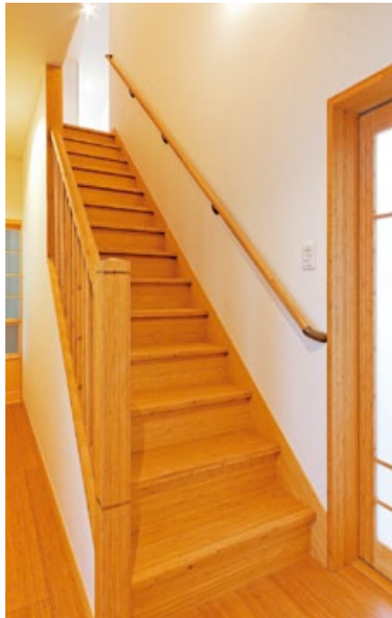
【本屋】 階段 踏板 蹴込み板 手摺 竹加工
